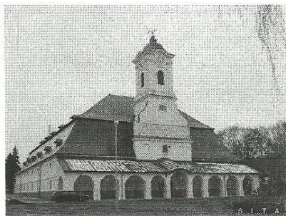
zrekonštruovaný sklad soli
